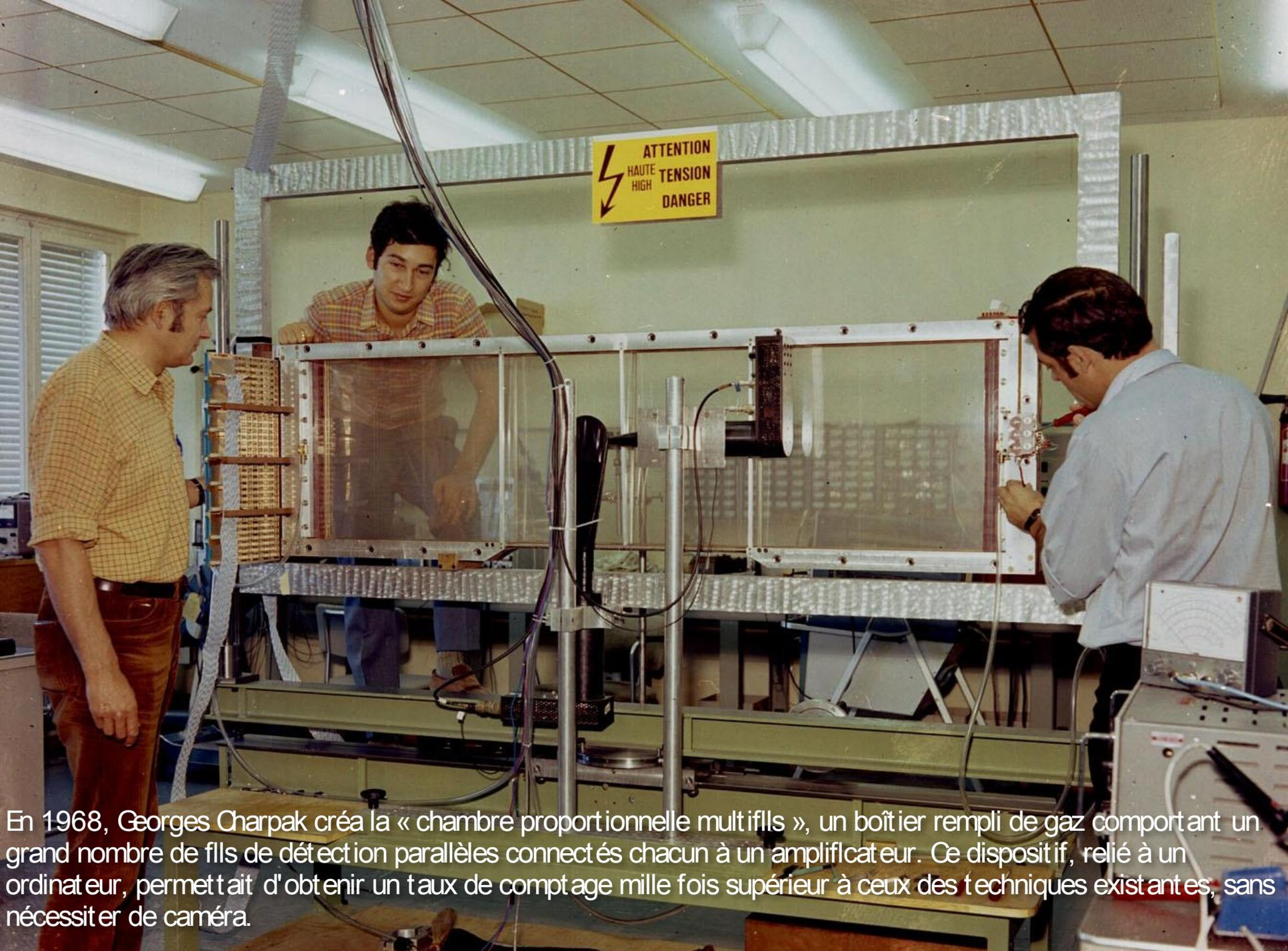
En 1968, Georges Charpak créa la « chambre proportionnelle multifils », un boîtier rempli de gaz comportant un grand nombre de fils de détection parallèles connectés chacun à un amplificateur. Ce dispositif, relié à un ordinateur, permettait d'obtenir un taux de comptage mille fois supérieur à ceux des techniques existantes, sans nécessiter de caméra.
