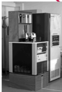
Installation du T1600 de Télémechanique au lycée Joffre, juin 1978
