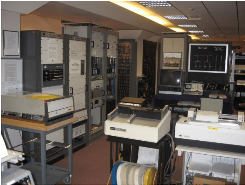
Vue de l'ensemble des équipements sauvegardés dans la salle de présentation d'Estel. Photo Estel
